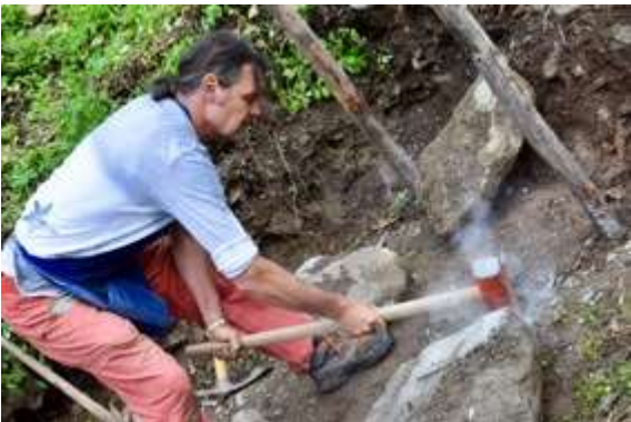
Abb. 56, 57: Bearbeiten und spalten der Steine mit dem Spaltschlegel
