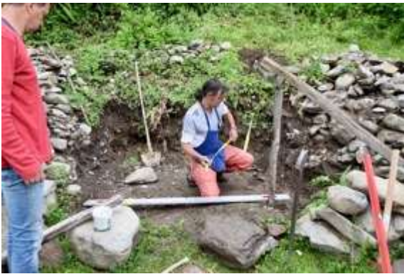
Abb. 53 – 55: 53 Festlegen der Neigung nach innen zur zukünftigen Hinterfüllung – ca . 10%; 54 Festlegen des rechten Winkels durch das Dreiecksseitenverhältnis 3 : 4 : 5; 55 Fertigstellung des Gerüsts für die rechte Nischenseite an dem sich die Trockensteinmauer orientiert.
