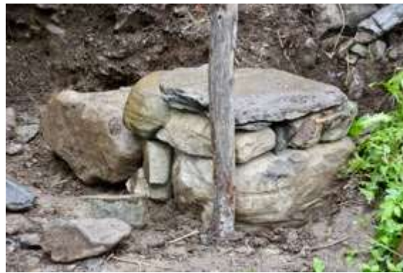
Abb. 63 – 66: Versetzen der ersten Ecke mit besonders großen Steinen am Boden und klare Verzahnung
