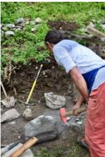
Abb. 56, 57: Bearbeiten und spalten der Steine mit dem Spaltschlegel
