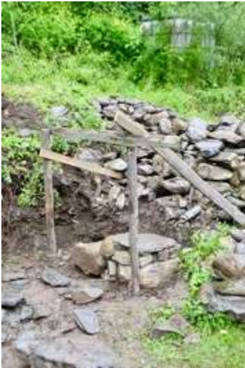
Abb. 63 – 66: Versetzen der ersten Ecke mit besonders großen Steinen am Boden und klare Verzahnung
