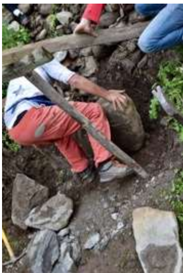
Abb. 61 – 62: Wälzen und Hebeln der Steine
